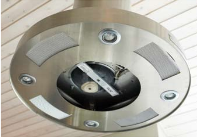
Fig. 240.4. Alle tilsigtede åbninger i konstruktionerne lukkes til, så de ikke har indflydelse på resultatet af testen.
